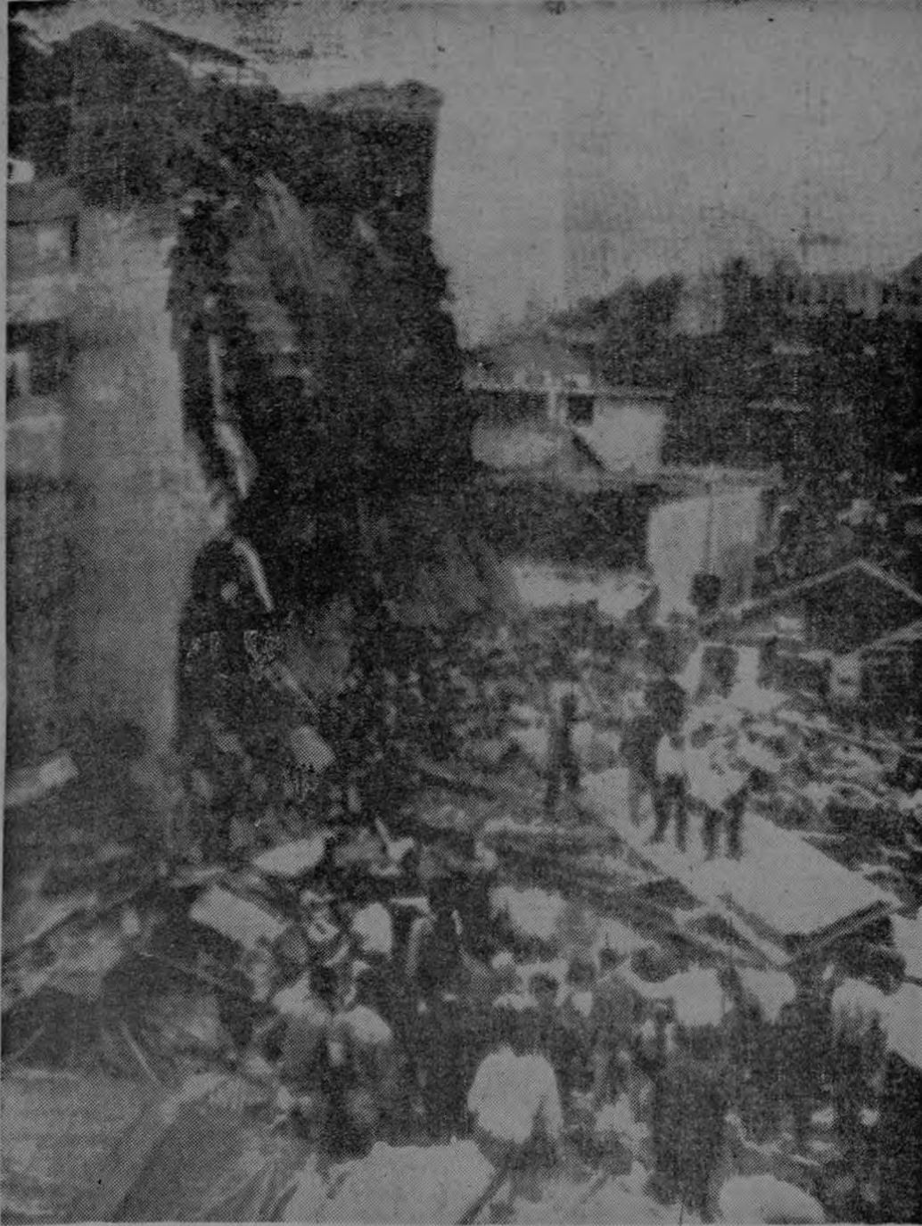
SEUL, Corea. 4 (AP). Cuadrillas de rescate buscan víctimas después que se derrumbó un edificio en el centro comercial de Seul matando por lo menos a diez personas. Se cree
